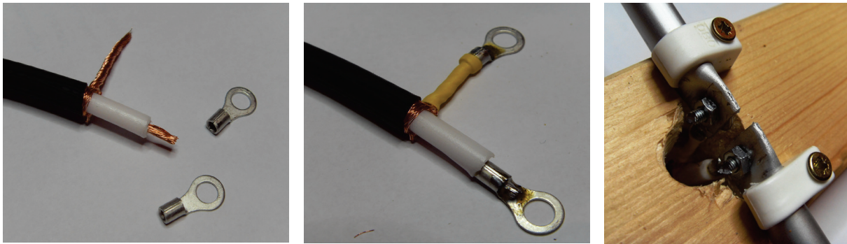
Abbildung 7: Vorbereitung des Koaxialkabels (links bzw. Mitte) und Verbindung zwischen Koaxialkabel und den Dipolelementen (rechts)
